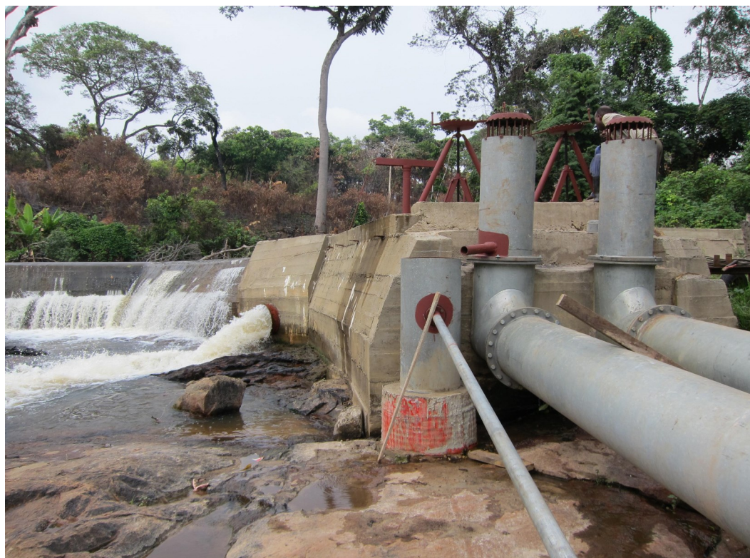
Project Elkap Congo - aangebracht door SOFIA
